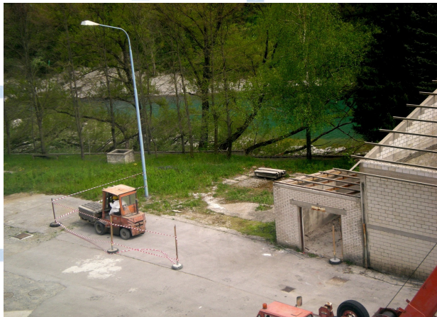
Odvoz a/c kritine na začasno skladiščenje.
