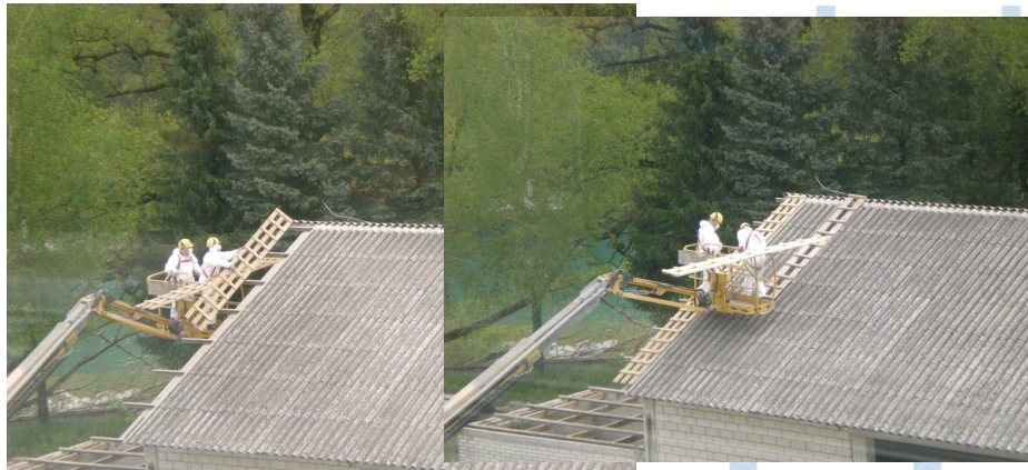
Namestitev pohodnih elementov
