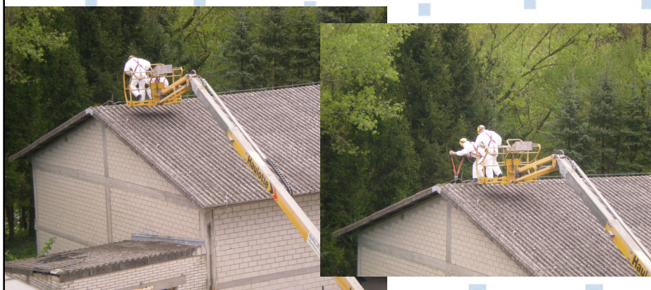
Pripravljalna dela (odstranjevanje strelovoda)
